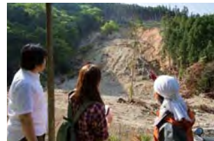
豪雨による崩壊土砂の動きを調査
