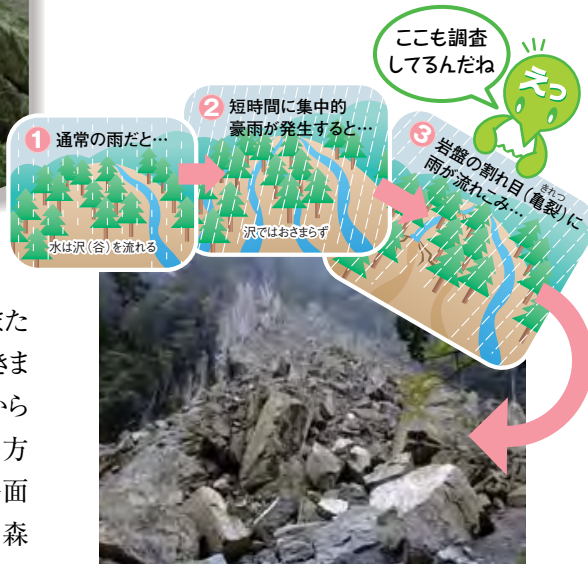
台風21号(2004年)の豪雨による宮川上流大杉谷での岩盤崩落
